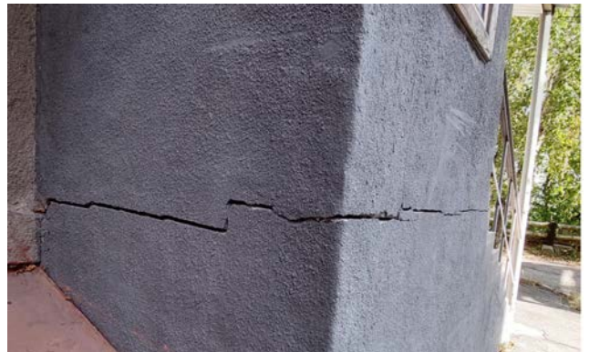
Рис. 12. Сліди руйнування на добудованих сходинок на південній стороні гуртожитку
